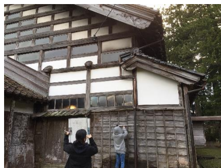
[写真5] 軒の出の実測調査の様子
