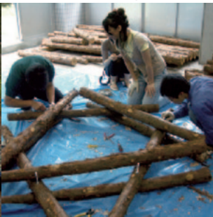
間伐材での木工沈床制作
