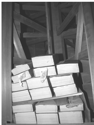
支柱を残して破損した輪蔵と大蔵経
