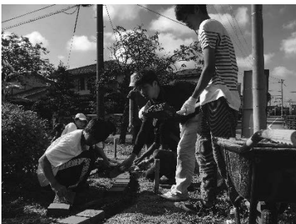
図12. モルタルでレンガを固定
